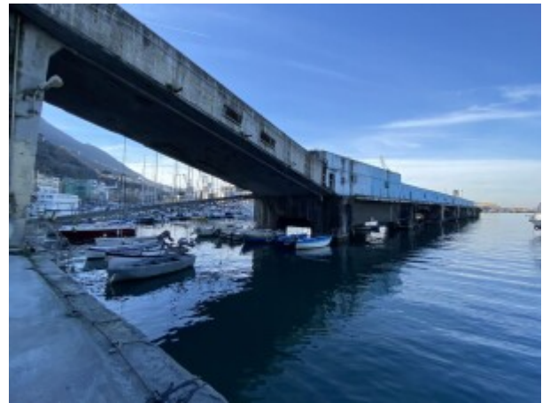
Castellammare di Stabia, area dei cantieri
