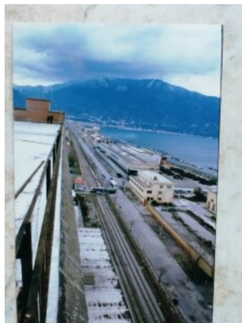
Il quartiere dall'alto prima della costruzione del porto turistico Marina di Stabia
